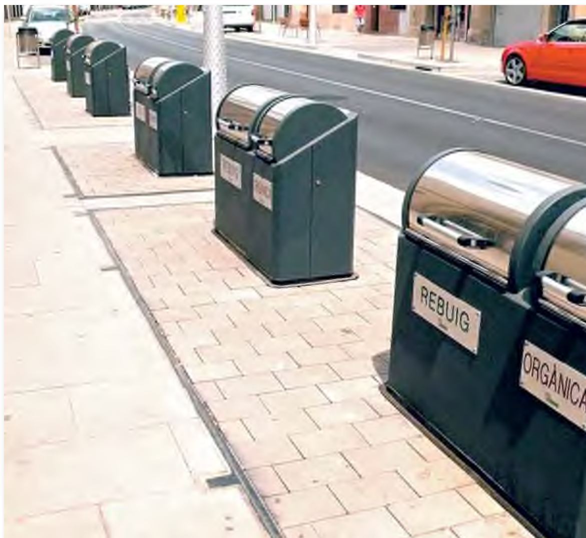
Els contenidors soterrats instal·lats a la carretera Laureà Miró
