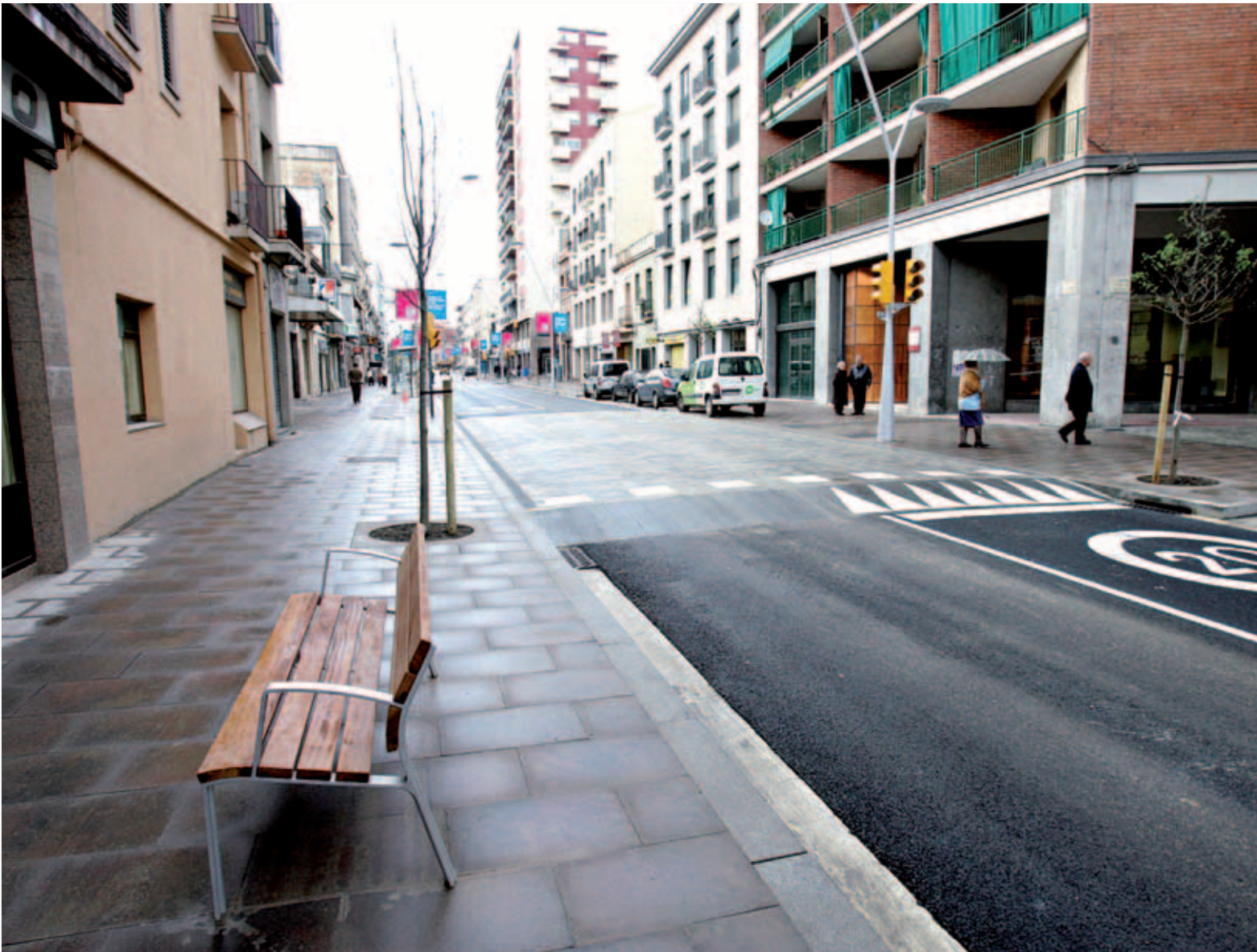
Remodelació carrer Laureà Miró, primera fase
