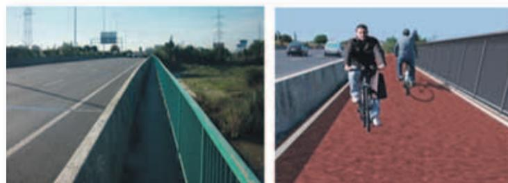
lliure per al nou vial projectat. La longitud total del pont és de 190 metres. Per fer l'ampliació s'ha respectat la situació de la calçada existent, amb els quatre carrils i el voral i barrera rígida de formigó existent
