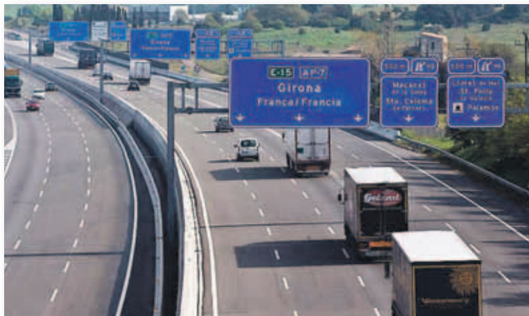
Imagen de la autopista AP-7
